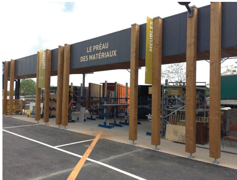
Le préau des matériaux avec les places de stationnement/dépôt devant
